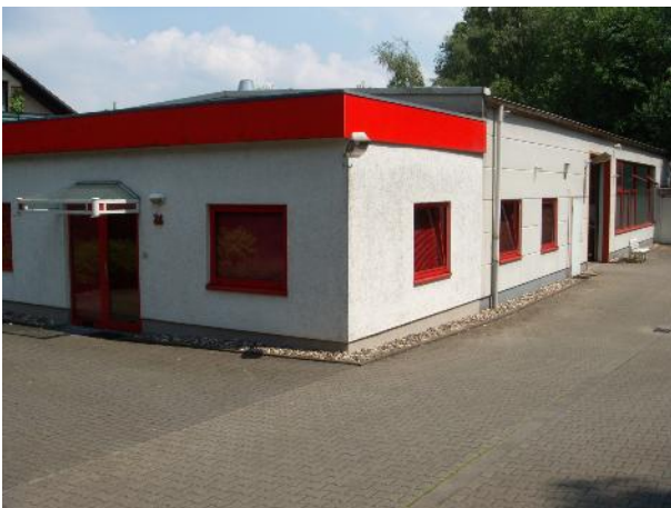
Hallenansicht Weilenburgstraße 26 Foto: A. Klomfass
