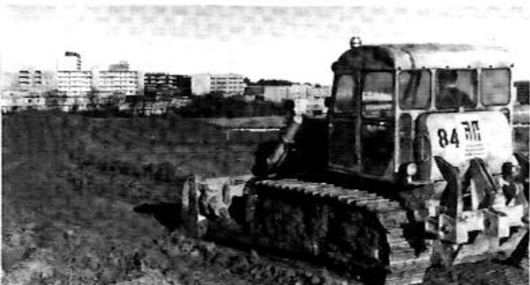
13. Februar 1968: Erdarbeiten in der Oberilp Foto: Stadtarchiv Heiligenhaus / WAZ
