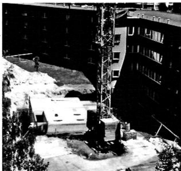
Das unterirdische Blockheizwerk mit Kohlebunker kurz vor der Fertigstellung. Sommer 1989. Foto: Klaus-Peter Kronenberg
