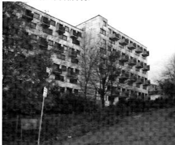
Die leeren Häuser Rhönstraße 10/12 warten auf den Abriss. Februar 2006. Foto: Alexej Nevolin
