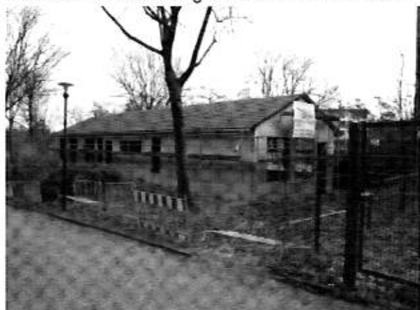
Neubau des Gebäudes für die Offene Ganztagschule (OGATA) und planierter Bereich für den Schulgarten. Februar 2006. Foto: Alexej Nevolin
