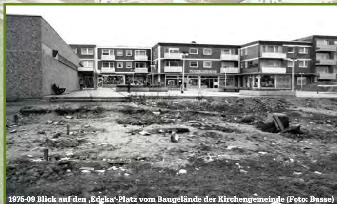
1975-09 Blick auf den ‚Edeka‘-Platz vom Baugelände der Kirchengemeinde (Foto: Busse)
